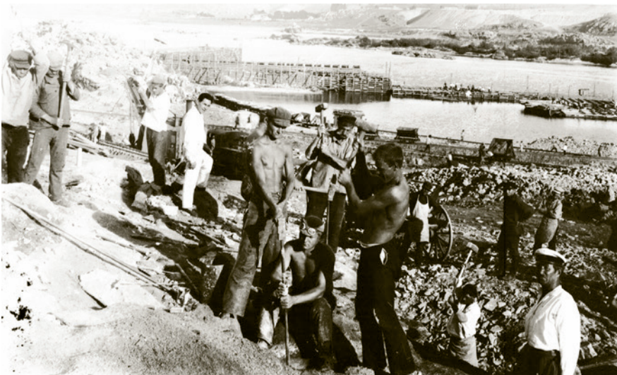
Буріння скель на будівництві Дніпрогесу. Запоріжжя, 1927 р.
