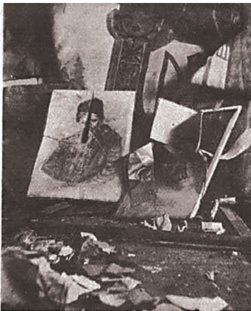
Зруйнована читальня «Просвіти», с. Княгиничі, Станіславівське воєводство (тепер Івано-Франківська область). 1930 р.
