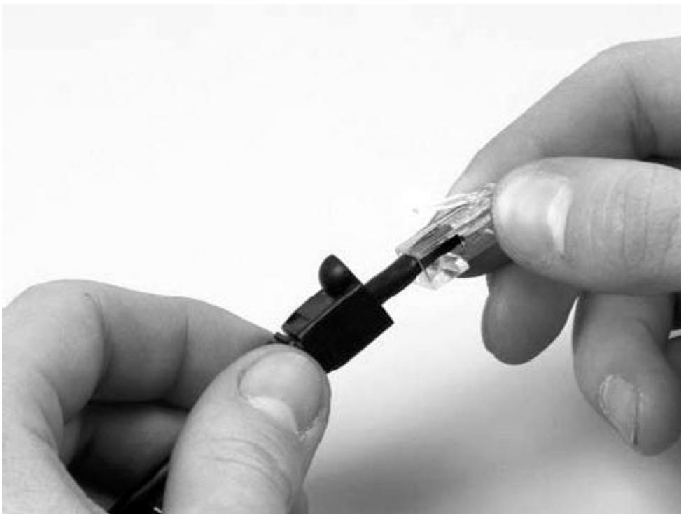
**Рис. 18.9.** Надеваем колпачок
