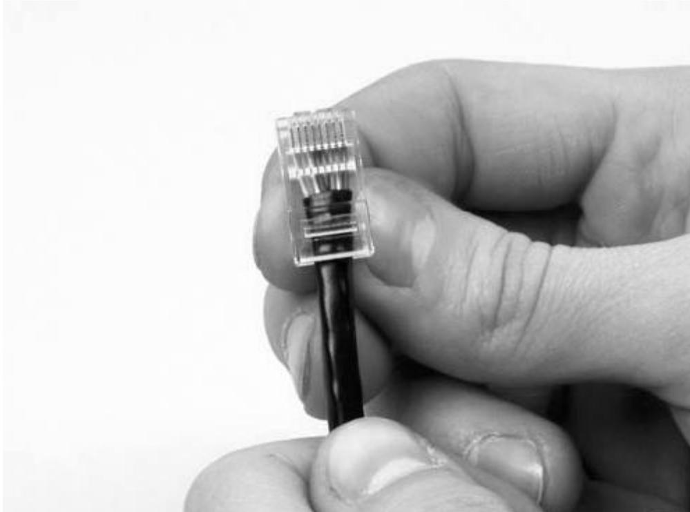
**Рис. 18.7.** Вставляем проводники в коннектор
