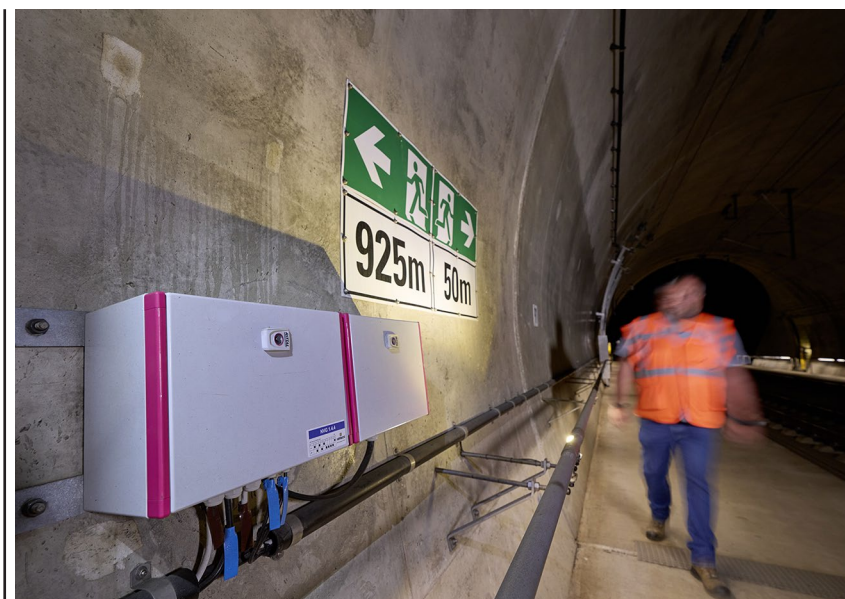
Рис. 1. Застосування пластикових шаф AX в тунелях
