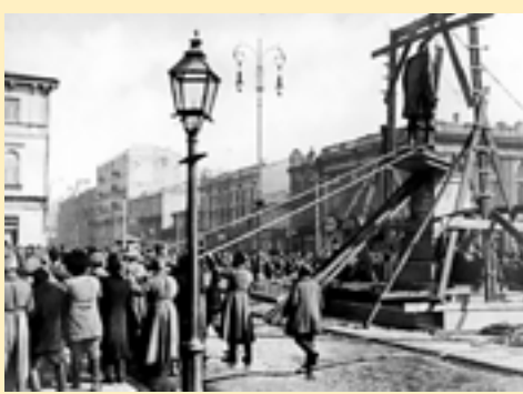
Демонтаж пам'ятника П. Столипіну в Києві. Березень 1917 р.
