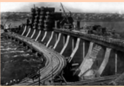
Будівництво Дніпровської гідроелектростанції. 1930 р.
