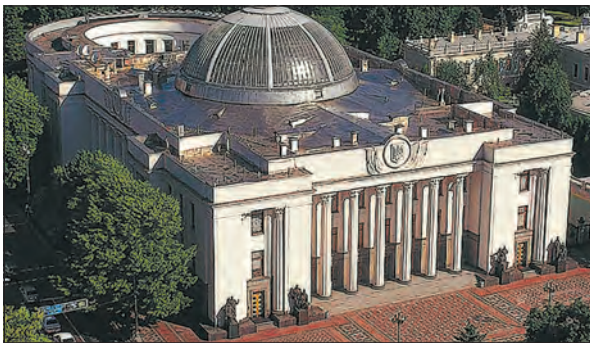
Будівля Верховної Ради України (місто Київ, вул. Грушевського, 5)
