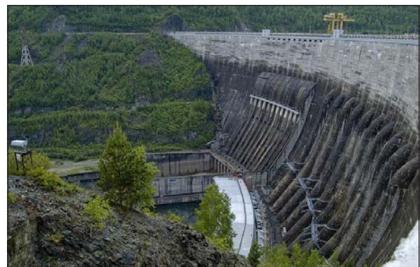
Мал. 1. Саяно-Шушенська ГЕС з Ангаро-Єнісейського каскаду — найпотужніша електростанція Росії.
