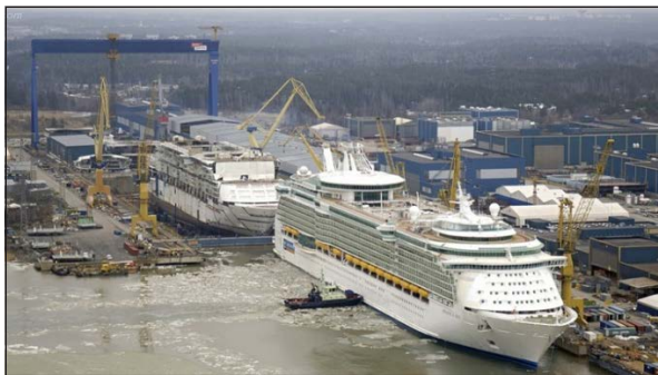
Мал. 1. Будівництво круїзних суден на верфі в місті Турку (Фінляндія).
