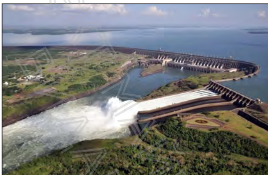
Мал. 1. «Ітайпу» (Бразилія) — одна з найпотужніших (14 МВт) ГЕС світу. Загальна довжина греблі складає понад 7 км, висота — 196 м.
