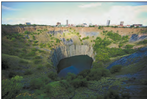
Мал. 5. Кар'єр із видобутку алмазів «Велика діра». Тривалий час роботи в Кімберлі велися відкритим способом. На згадку про той час залишився величезний заповнений водою кар'єр діаметром у 1,5 км і завглибшки майже 200 м.
