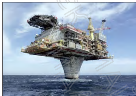
Мал. 3. Унікальна нафтодобувна платформа «Драген» (Норвегія) — є справжнім дивом інженерної думки — багатоповерхова споруда стоїть на одній 280-метровій бетонній «нозі», з яких 250 метрів ховається у морі.
