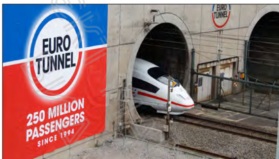
Мал. 3. Євротунель під Ла-Маншем з'днує Францію та Велику Британію, є складовою одного з європейських транспортних коридорів. Тунель має довжину близько 51 км, із них 39 км — безпосередньо під дном моря.
