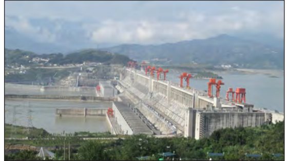
Мал. 1. ГЕС «Три ущелини» на річці Янцзи (Китай) — найпотужніша у світі (22,5 ГВт). Протяжність греблі — 2,3 км, висота — 182 м. Під час будівництва ГЕС було затоплено 13 міст та переселено 1,3 млн осіб.
