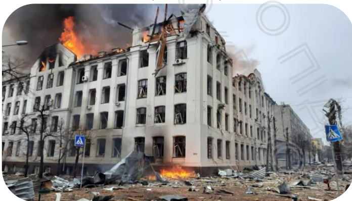
Будівля обласної Харківської адміністрації після ракетного обстрілу центру міста. У результаті обстрілу загинуло понад 20 осіб. 23 березня 2022р.
