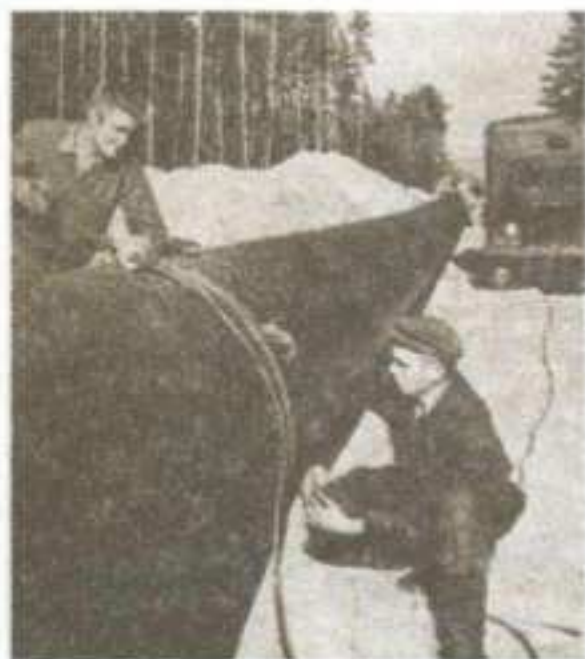
Будівництво газопроводу Шебелинка–Острозька. 1960 р.
