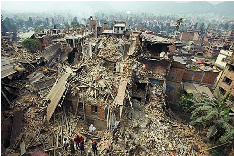
Рис. 3.4. Наслідки землетрусу в Непалі 2015 р.
