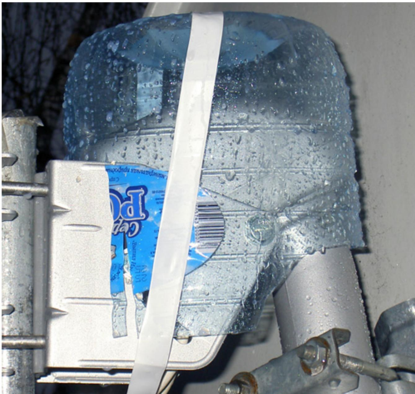
Которая защищает мотор от дождя и льда.
