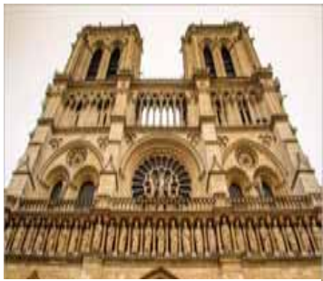
Собор Паризької Богоматері Нотр-Дам (початок будівництва – 1163 рік)
