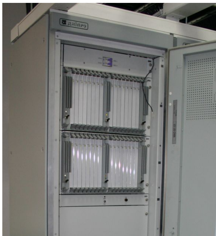
Рисунок 12.4 – Размещение БА064-01 в шкафу
