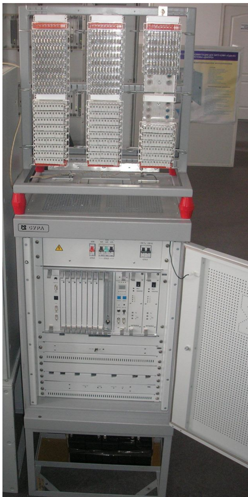
Рисунок 2.2 – Внешний вид телефонной станции емкостью 240 аналоговых АЛ
