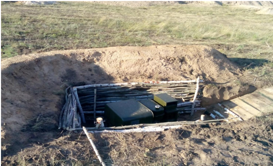
Рисунок 3.54 – Спосіб зменшення розповсюдження звуку працюючого агрегату
