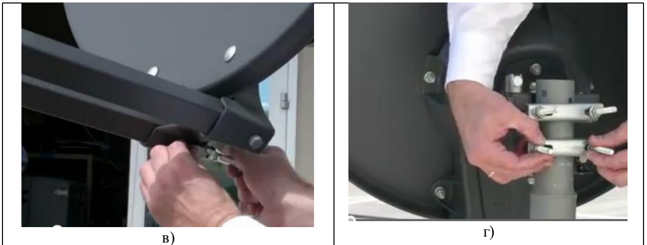
Рис. 1.11 Порядок монтажу антени з блоком прийомо-передавача
