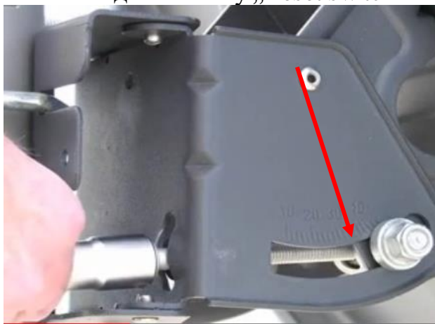
Рис. 1.14 Попереднє виставлення азимута і кута місця
