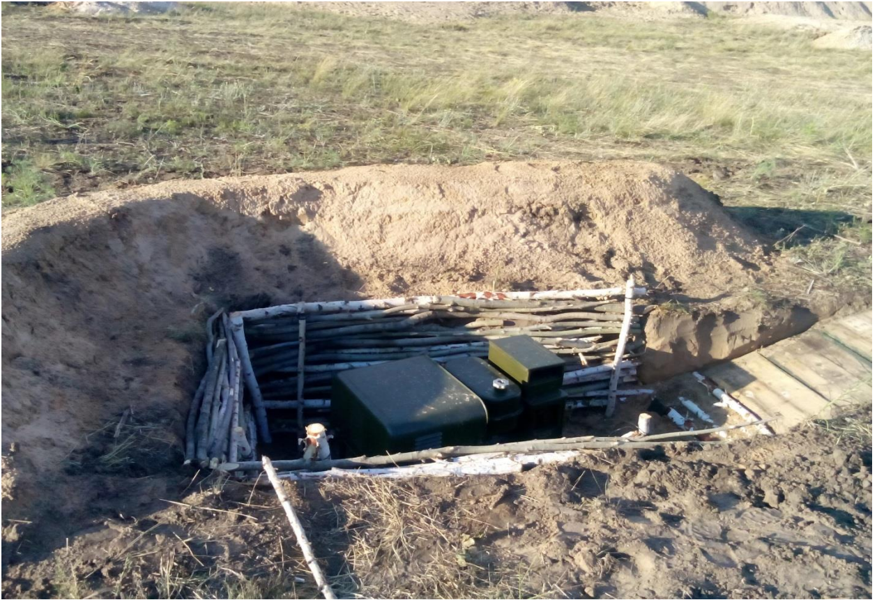
Рис. 1.7 Спосіб зменшення розповсюдження звуку працюючого агрегату
