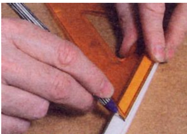
Рис. 36 Разметьте угловые соединения на новом уплотнителе
