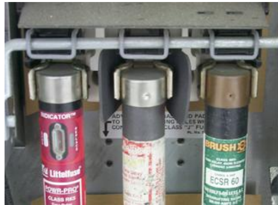
Перегрів контактної роз'єму запобіжника
