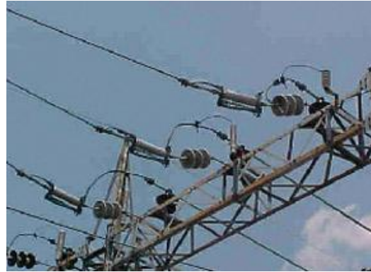
Контактне з'єднання з перегрівом на порталі підстанції (виміряна з використанням телескопічного об'єктива температура з'єднання складає +225 °С)
