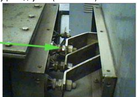
Перегрів болтового з'єднання шинного моста трансформатора
