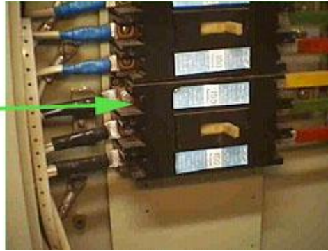
Перегрів ввідного затискача автоматичного вимикача
