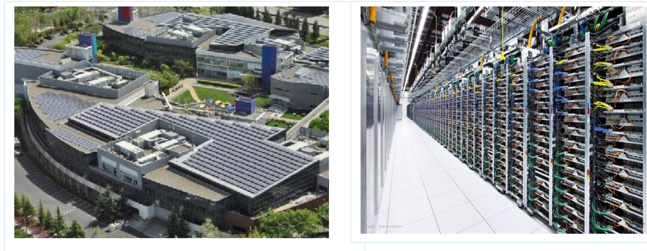
Рис. 2.4. Зовнішній (зліва) і внутрішній вигляд, зі стойками (шафами) дискових накопичувачів (праворуч), одного з дата-центрів компанії Google
