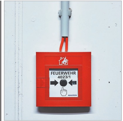
Рис. 3. Щоб надійно виключити хибні тривоги, необхідно встановити відповідну пожежну сигналізацію з ручним керуванням
