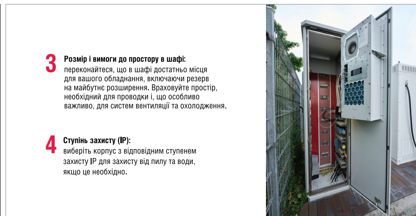
Рис. 2. Розмір і вимоги до простору в шафі, ступінь захисту (IP)
