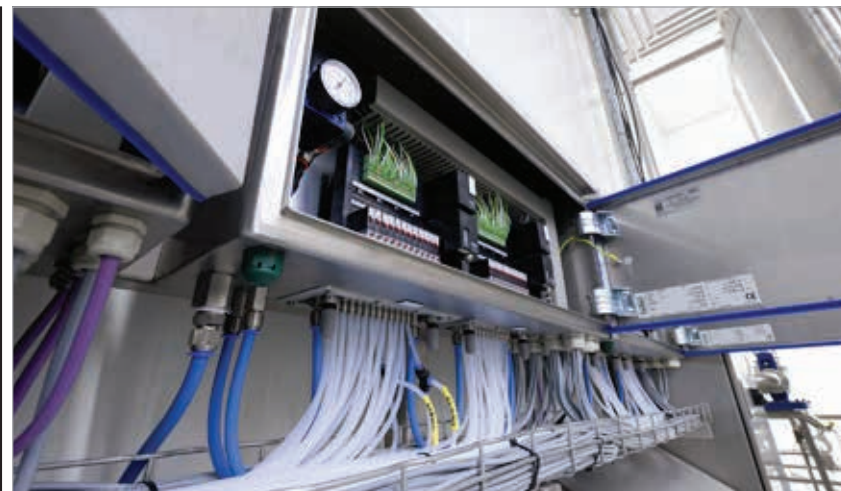
Рис. 2. Шафи AX мають легкий доступ знизу для зручного управління кабелями та проводкою
