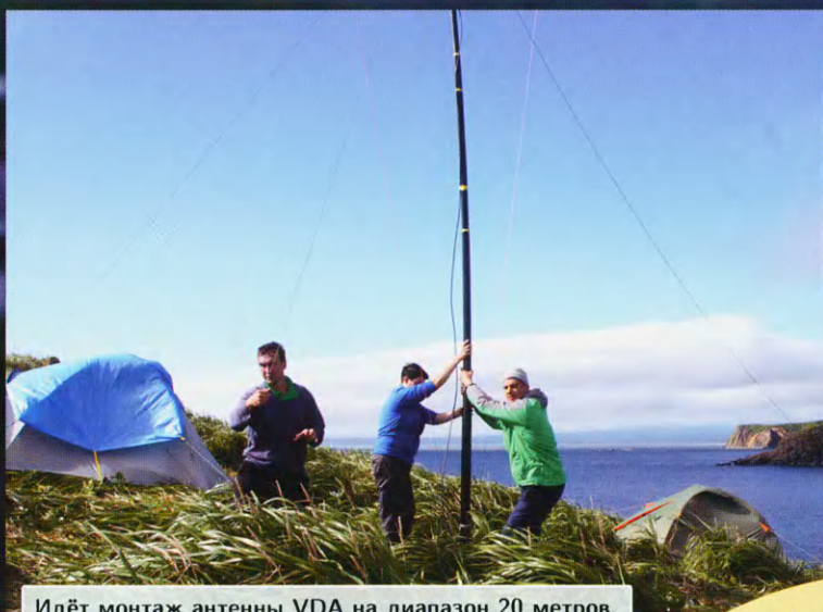
Идёт монтаж антенны VDA на диапазон 20 метров.
