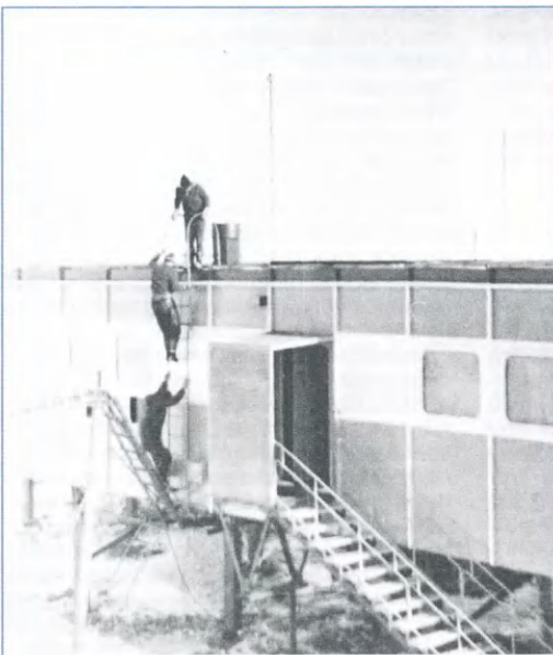
Ремонт вертикала 4К1А в помещении приёмного радицентра.
