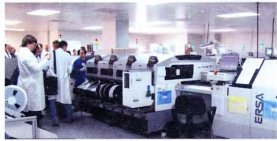
Автоматический установщик компонентов NXT.
