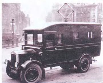
Английский пеленгатор времён Второй мировой войны, который был установлен на автомобиле шотландской фирмы Albion Motors.
