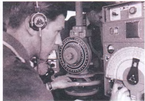
Мобильный вариант пеленгатора выпускался компанией Telefunken с 1938 г. Пеленгатор также использовался в Швейцарии. Тактико-технические характеристики пеленгатора: чувствительность — 1,5...10 мкВ, диапазон частот — 75 кГц...3,33 МГц.
