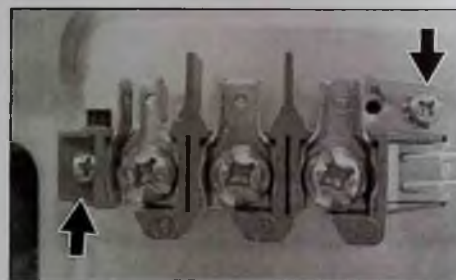
Рис. 12. Замена клеммной колодки
