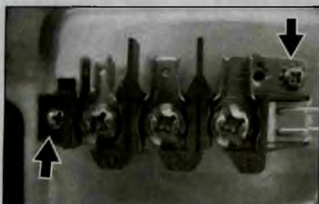
Рис. 17. Замена клеммной колодки
